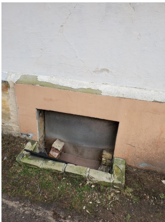
7 pav. Rūsio lango šviesduobė
