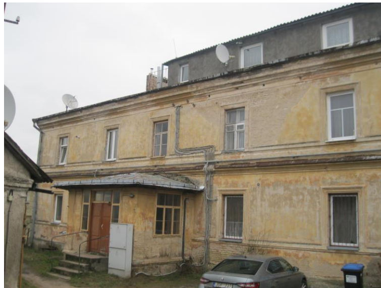
1 pav. Pastato fasadas iš pietvakarių pusės (bendras vaizdas)
